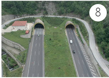
Bolu Dağı Tüneli
